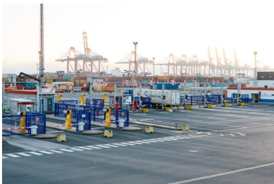
Bildunterschrift: Am Ende der Pilotphase waren bereits etwa ein Drittel der knapp 1.000 täglich abgefertigten Lkw über Truckgate vorgeplant.
